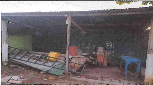
Foto 5: Sustitución de torta de cemento.
