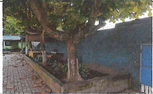
Foto 2: El muro perimetral interior del establecimiento
