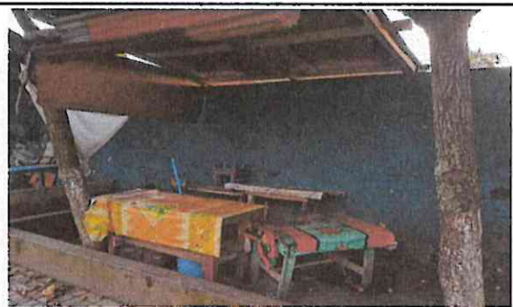
Foto 6: sustitución de torta de cemento
